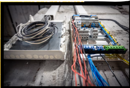
Suministro de materiales eléctricos
